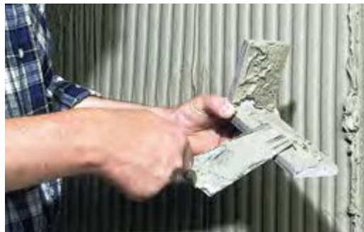
Kleberauftrag im kombinierten Verfahren („Floating-Buttering“)
