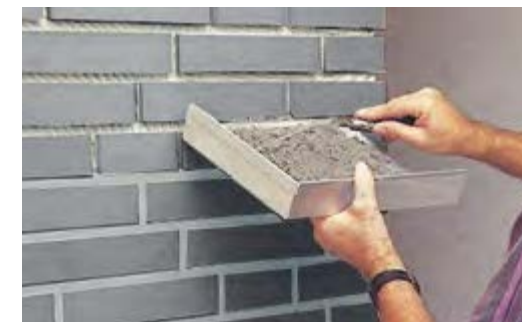
Sauberes Verfugen mit Fugeisen und Fugblech
