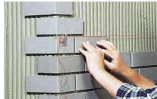
Setzen der Flächenriemchen mit Hilfe einer Schnur
