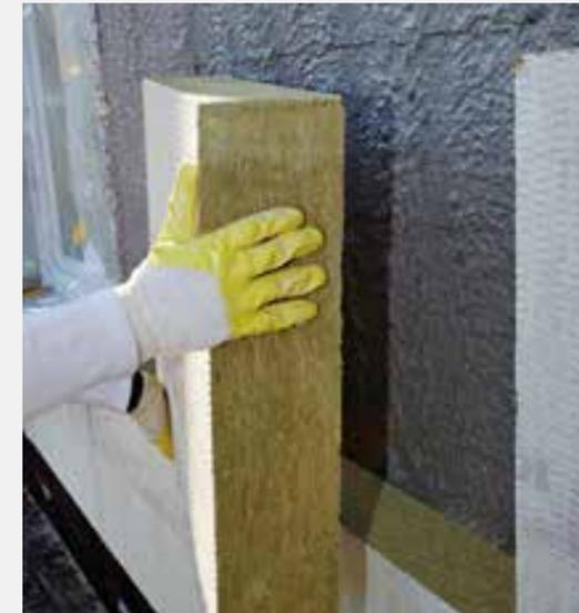
Die klebeseitige Beschichtung von Coverrock X-2, Coverrock II als auch Speedrock II erlaubt auch den zeitsparenden Auftrag des Klebemörtels auf den Untergrund.
