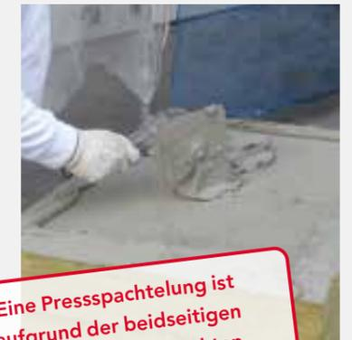
**Eine Pressspachtelung ist aufgrund der beidseitigen werkseitig aufgetragenen Beschichtung nicht mehr nötig!**
