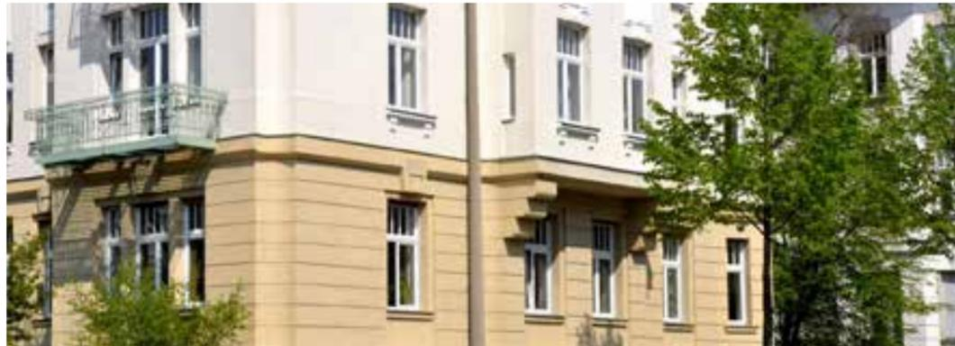
Auch WDVS-Fassaden, die mit einer Dämmung aus Steinwolle energetisch ertüchtigt wurden, können vielfältig gestaltet werden. Mit der Coverrock Deko z. B. kann eine Fassade mit Bossen ausgeführt werden.
