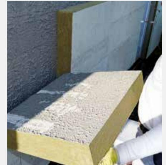
Es ist mindestens eine Verklebung der Platten/Lamellen von 40% (Klebefläche) zu erreichen. Beim Einsatz als Brandriegel/-barriere 100%.
