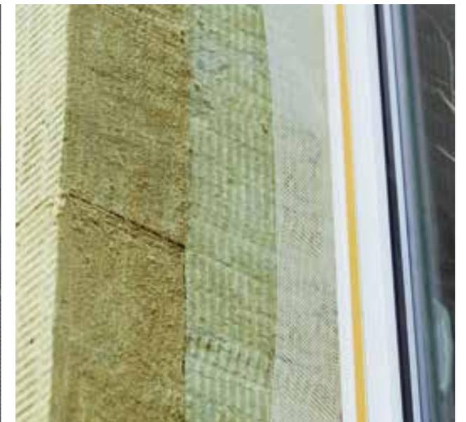
Dämmung bis in den kleinsten Winkel: Zur Vermeidung von innenseitigen Feuchtheitproblemen im Fensterbereich ist ein lückenloser Anschluss der Dämmung an das Fenster herzustellen.
