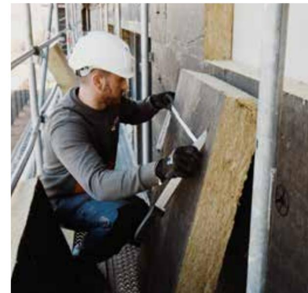
Fixrock Fassadenprodukte mit Vlieskaschierung:
